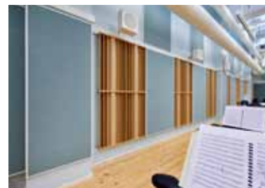
Ovan: Detaljbild av tyginkädda väggabsorbenter och diffusorer av trä.
